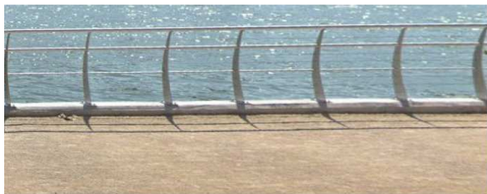
Remplacement du garde-corps quai de Chatillon :
